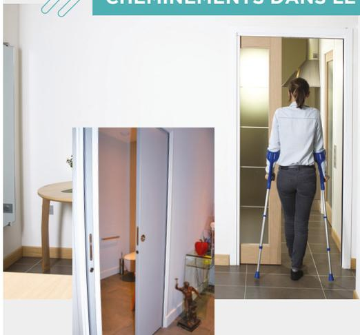
**Afin de faciliter le cheminement dans le logement, les portes d'accès auront, idéalement, une largeur de passage de 90 cm minimum.**
