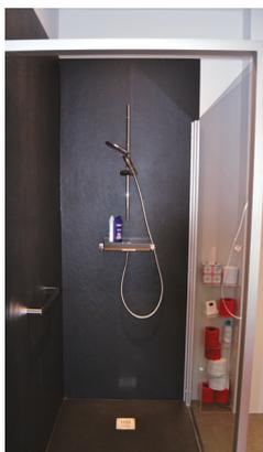
**Envisager des revêtements** muraux facilitant l'entretien comme la mise en place de faïence à grands carreaux ou panneaux de largeur et hauteur de parois afin de minimiser les joints dans le but de limiter les développements fongiques.
