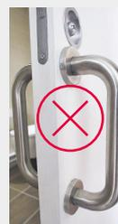
Les poignées suivent les recommandations indiquées dans le point précédent. Sur les portes à galandages, la poignée ne doit pas entraver une ouverture totale garantissant les 90 cm de passage.
